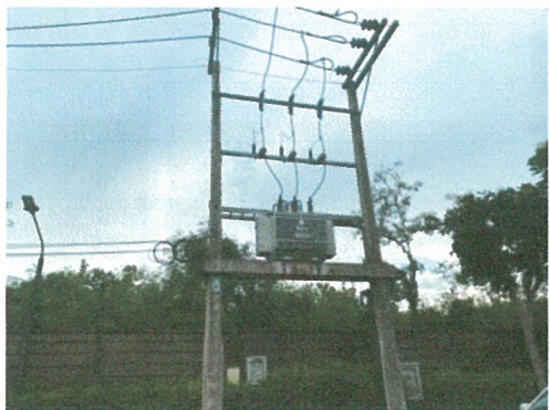
รูปภาพที่ 2.40 หม้อแปลงไฟฟ้า
