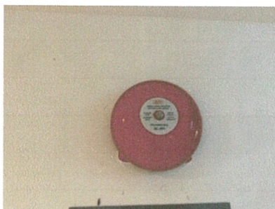
อุปกรณ์ส่งสัญญาณหนีไฟแบบกริ่ง
