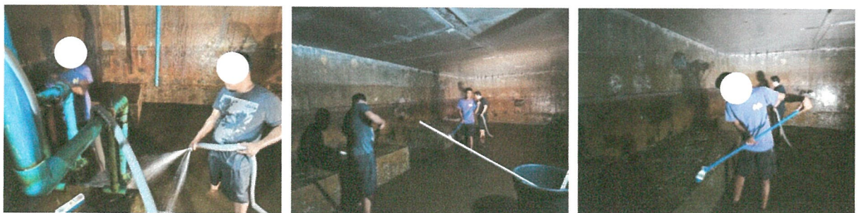
รูปภาพที่ 2.24 การล้างถังเก็บน้ำ
