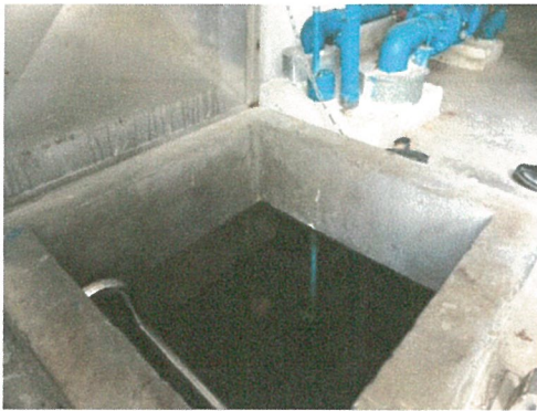
รูปภาพที่ 2.25 ถังเก็บน้ำใต้ดิน
