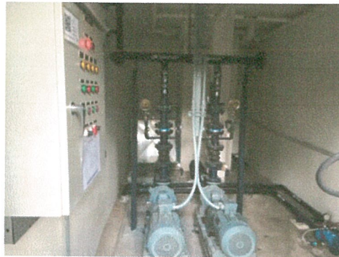
รูปภาพที่ 2.31 เครื่องสูบน้ำฝน
