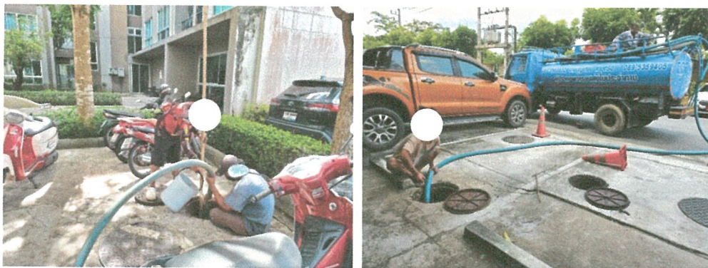
รูปภาพที่ 2.23 การสูบล้าง/ไขมัน
